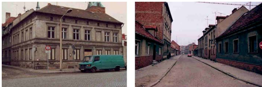
Abb. 7: Wohngebäude und Straßenzug in Stendal mit erhöhtem Sanierungsbedarf (Aufnahme 1992)
