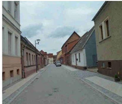
Abb. 8: Wohngebäude und Straßenzug der Abb.7 mit Fördermitteln saniert (Aufnahme 2005)
